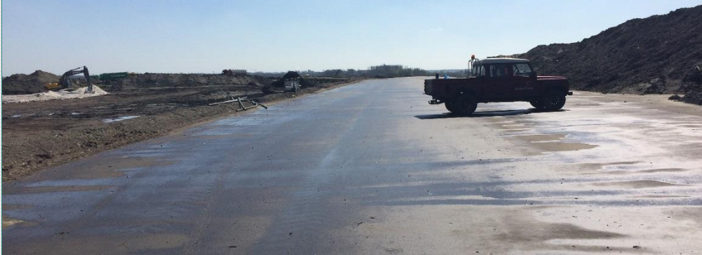
Verwerking van 22.000 ton Vandolith op De Stainkoeln (Groningen)
