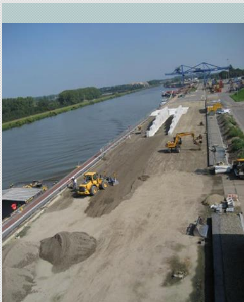
Vandolith® verwerkt op het haventerrein in Wesseem, tevens aangebracht als laaddock.
