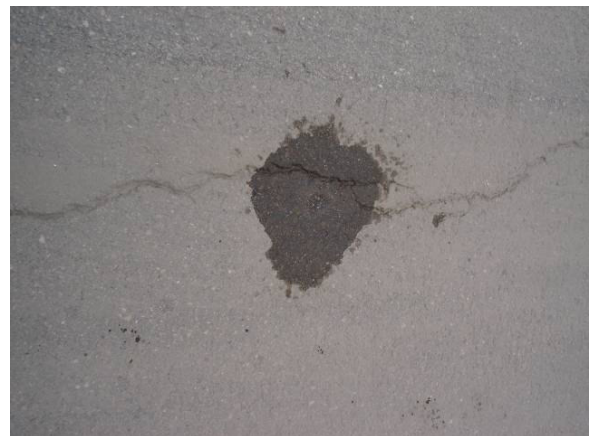
Detail van de scheur (natgemaakt)
