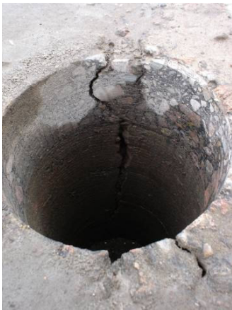
Scheur in boorgat
