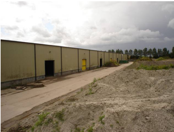
Overzicht over de weg aan de zijkant van de hal
